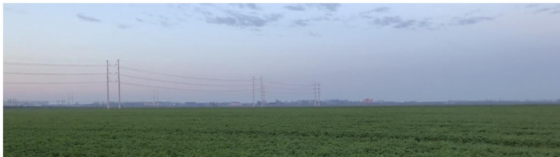
Figuur 1: Hoogspanningsmasten vanaf Lisserweg
