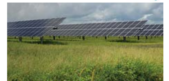
Fig. 6.3: Door de trackers met voldoende tussenruimte te plaatsen is er volgens de berekeningen van TNO/Deltares tot circa 1,5 m waterdiepte voldoende licht voor plantengroei.
