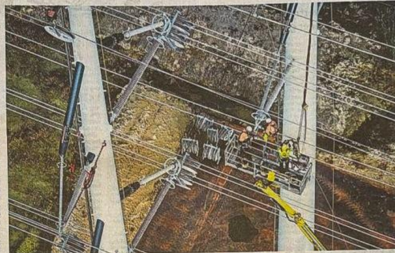
Werkzaamheden aan het stroomnet.
