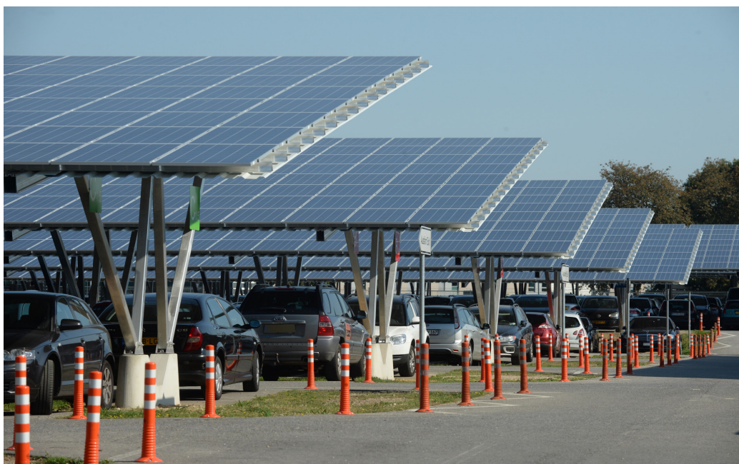
Afbeelding: Vliegveld Weeze heeft recent 4MW aan PV-carports geïnstalleerd.
