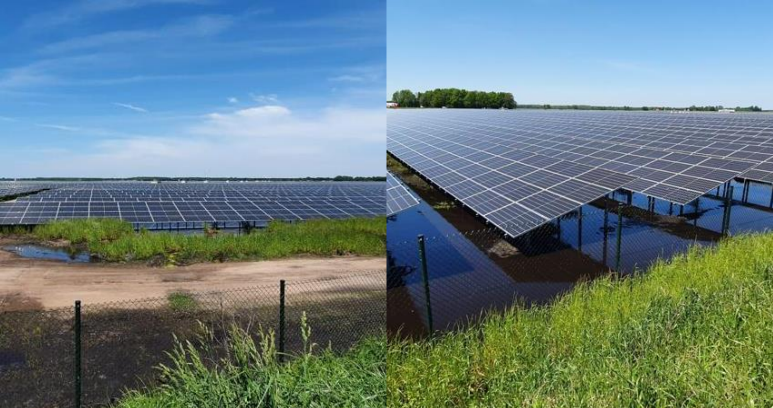
Opzetten waterpeil in veenweidegebied i.c.m. zonnepanelen. Locatie: Buinerveen, Drenthe
