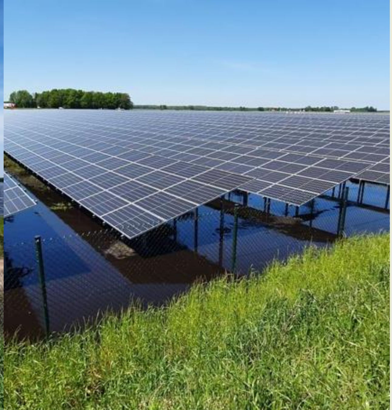
Opzetten waterpeil in veenweidegebied i.c.m. zonnepanelen. Locatie: Buinerveen, Drenthe
